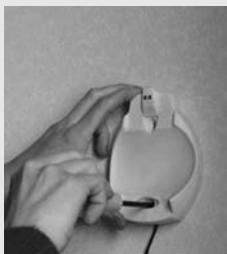
Segnate i 2 punti di fissaggio del supporto. Forate la parete (trapano con punta da 6 mm).
