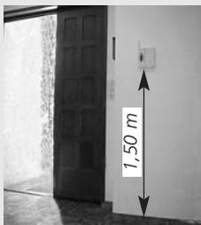
La postazione interna può essere appoggiata su di un mobile (sollevate i due piedini estraibili sul retro) o fissata a parete. In quest'ultimo caso, scegliete una superficie liscia. Per una buona accessibilità e facilità d'uso, è consigliato installare il supporto a circa 1,50 m dal pavimento.
